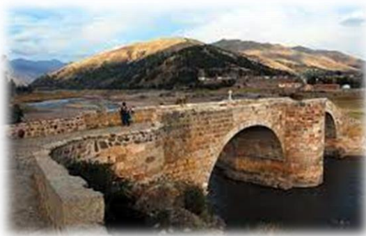
Puente de Calicanto o Rumichaka
