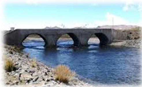
Puente de Santa Bárbara
